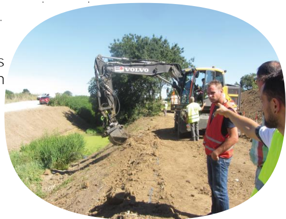
Réunion de chantier sur la Viredonne
