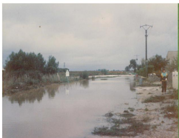
Lotissement des Crocasses, crue du Dardaillon Ouest, 28-29 octobre 1987
