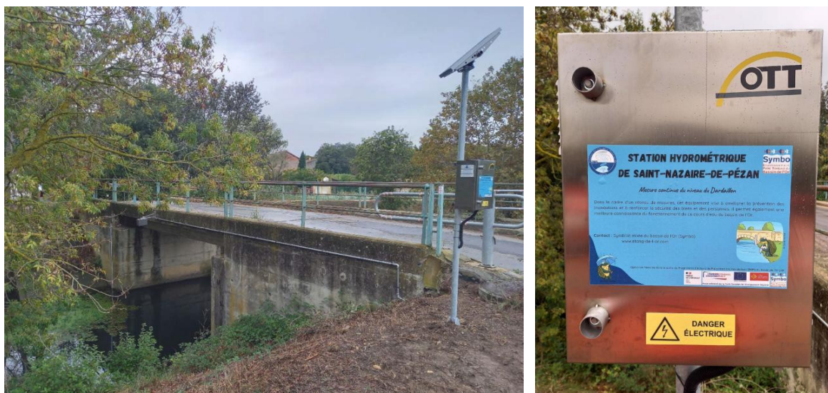
Station hydrométrique déployée sur le Dardaillon à Saint-Nazaire-de-Pézan, avec son panneau d'information
