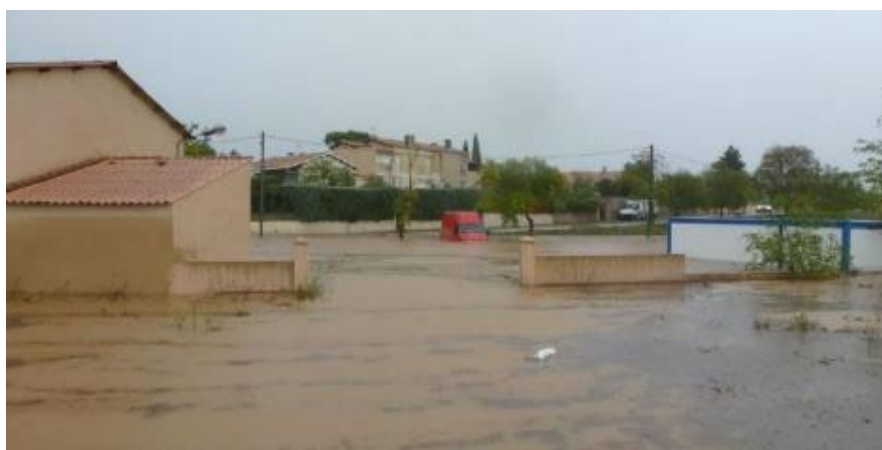
Figure 20 - Inondation du Centre d'Incendie et de Secours (CIS) de Castries (©AURORE)
