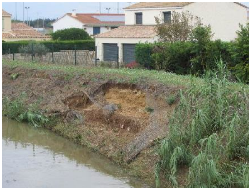
Figure 19 - Erosion de la digue classée de la Balaunie à Mauguio (©F.Imbert)
