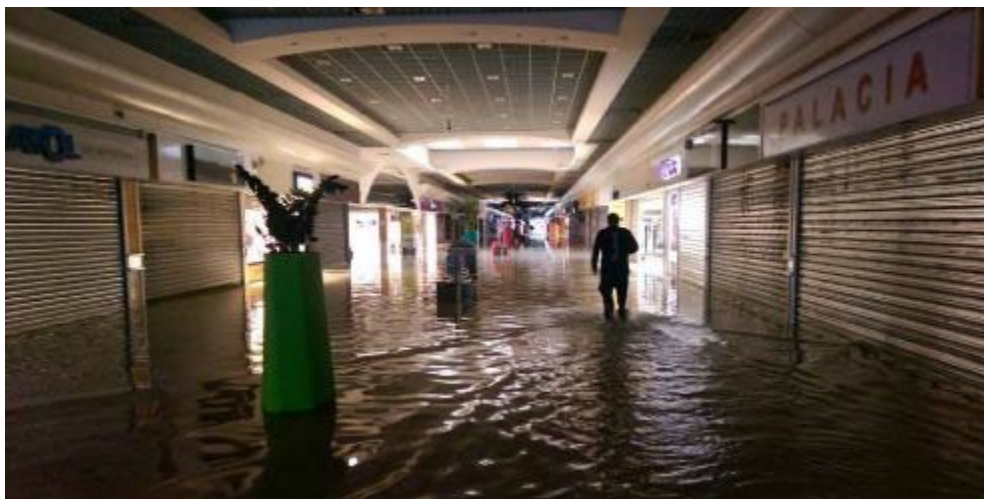
Figure 23 – Inondation de la galerie commerciale Auchan à Pérols le 29/09/2014 (© N.S. Soler)
